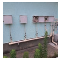
エルソナ用に体育館の 外壁にガス配管を設置
