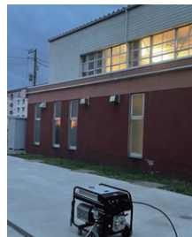
綾瀬市の体育館に 導入されたエルソナ
